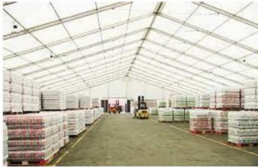
เตนท์โครงเหล็กหลังคาเหล็กถาวร
